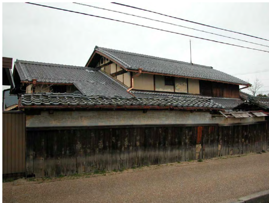
屋根の修理工事が終わった旧中江家住宅
