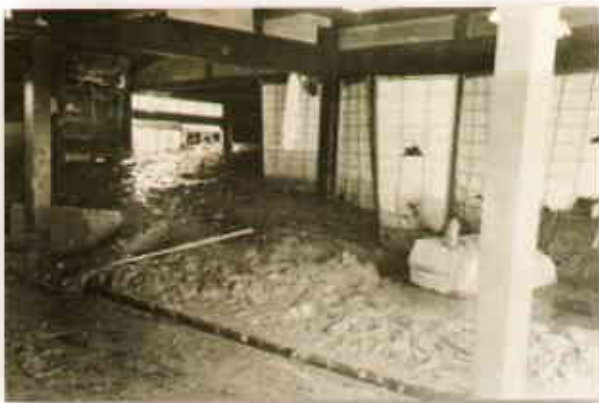
▲住宅内に流れ込んだ土砂
